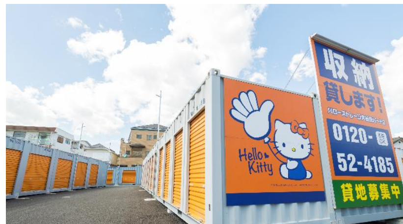
屋外型コンテナタイプストレージ
