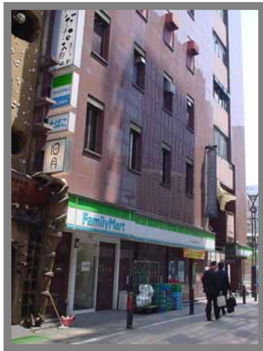
店舗開発研究所新橋 年間利回り %
