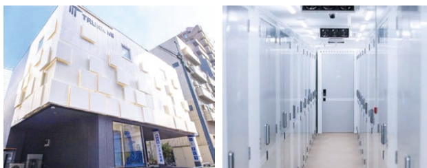
屋内一棟型、全174室、最寄り駅から約3分と好立地に位置する「TRUNK Mi 勝どき」
