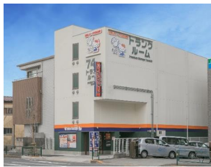
ハローストレージ田無プレミアム 鉄骨造 74室
