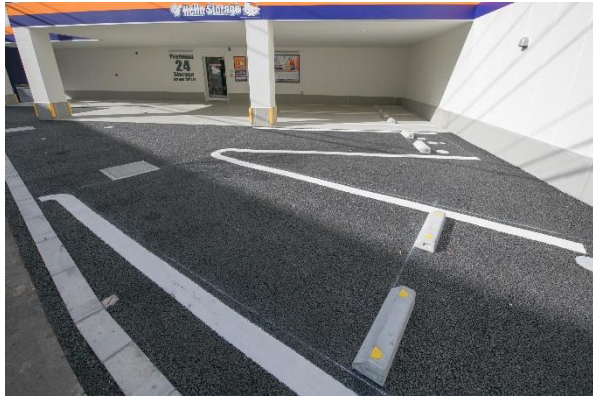
屋外駐車場を完備
