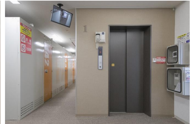
室内の監視モニター
