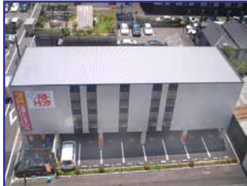
東京・飯田橋 (リニューアル現場例)
