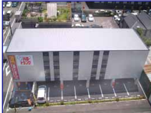
東京・飯田橋 リニューアル現場例
