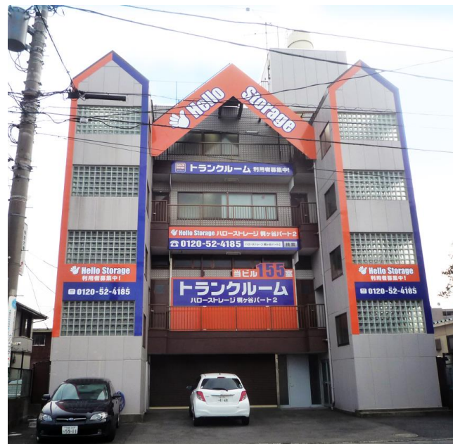
ハローストレージ梶ヶ谷パート2 (神奈川県川崎市宮前区) 155室
