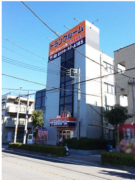
ハローストレージ蕨 (埼玉県蕨市中央) 211室
