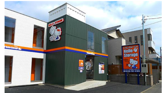
ハローストレージ松戸常盤平プレミアコンテナ 2017年3月オープン
