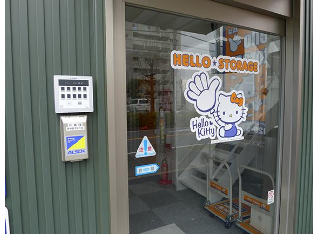
エントランスは自動ドアを採用
