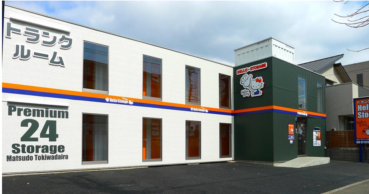
ハローストレージ松戸常盤平(システムコンテナタイプ) 2017年3月オープン
