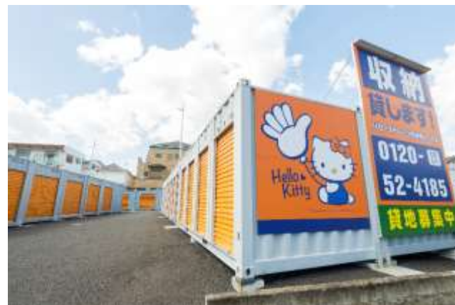
屋外型コンテナタイプストレージ
