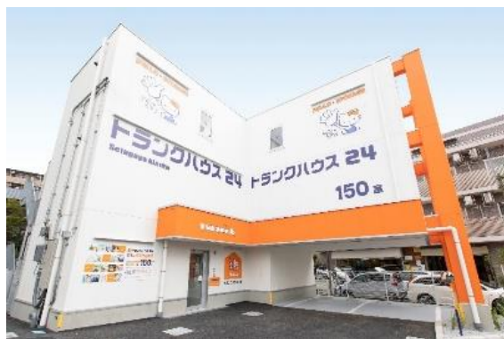
トランクハウス24世田谷砦 重量鉄骨造 150室
