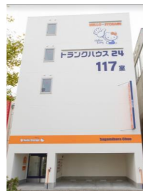
トランクハウス24相模原中央 鉄骨造 117室
