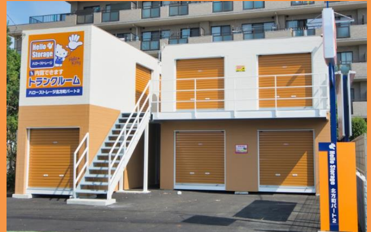
ハローストレージ(屋外タイプ) HS北方町パート2 27室 JR総武線 下総中山駅 車10分
