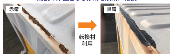
腐食の原因となる赤錆を黒錆に転換
