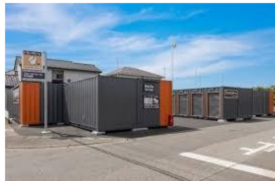
屋外型トランクルーム
